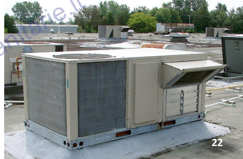
Unità HVAC (Heating, Ventilation, Air Conditioning) di condizionamento ambientale sul tetto con vista della presa di aria fresca.
